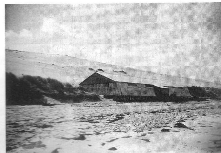
"Août 48. Hangar du centre du Pyla où nos tentes sont dressées à l'intérieur".
